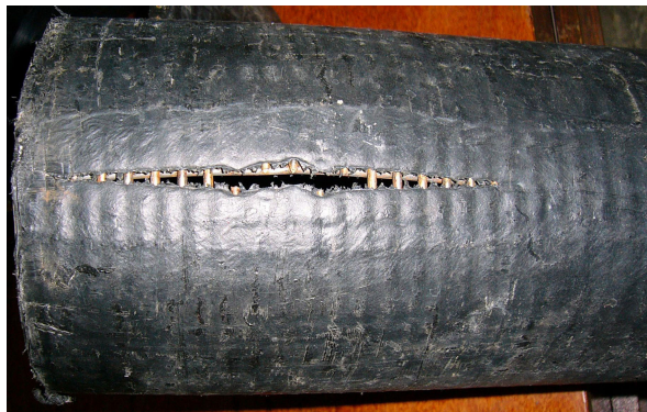
Рис. 5. Разрушение трубы ПАТ под внутренним давлением
